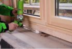
Verarbeitung des Fensteranschlusses mit FM230.
