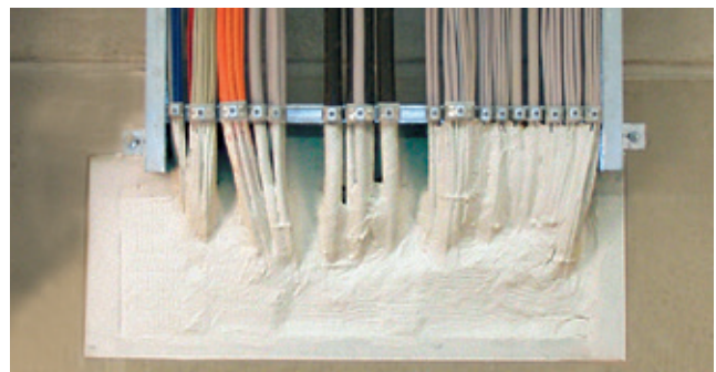
Einbaubeispiel: ISO-FLAME PLATTE S 90
