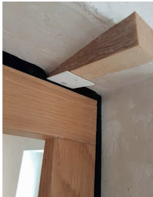
Beim Keilen KU-Klötze unterlegen.
