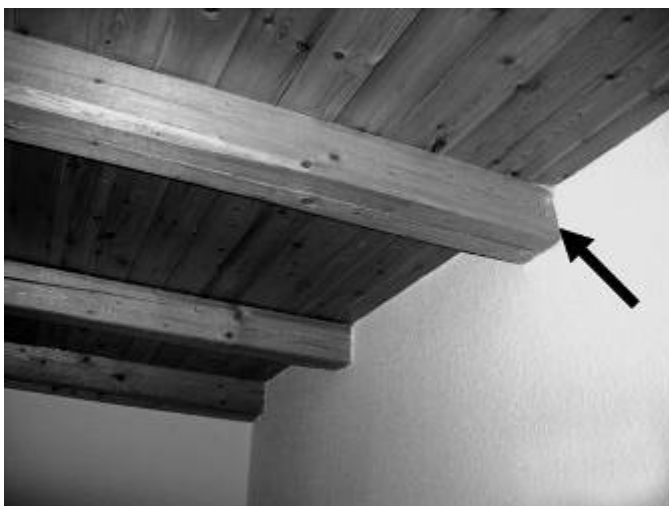
Bild 10 Deckenbalkendurchführung in die Wand
