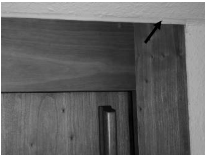
Bild 9 Einbauschränk, Abdichtung gegen Dachschräge
