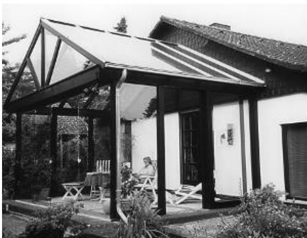
Bild 6: Wintergarten, Anschluss der Holzbalken zum geputzten Baukörper
